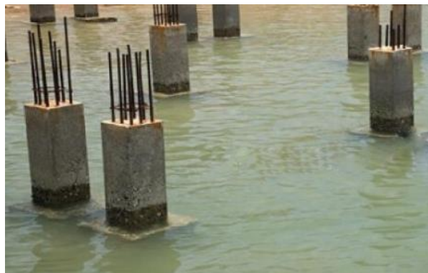
Gambar 24. Pondasi tiang pancang
