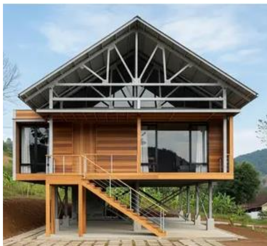
Gambar 5. Perpaduan Struktur Kayu dengan Baja Ringan
